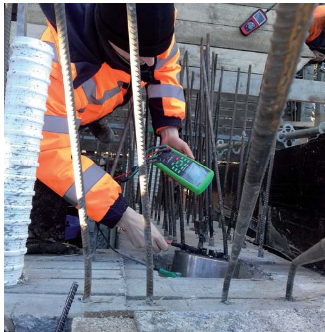
Obr. 7 Meranie elektrického odporu kábla pred injektážou Fig. 7 Measuring of tendon's electric resistance before grouting
