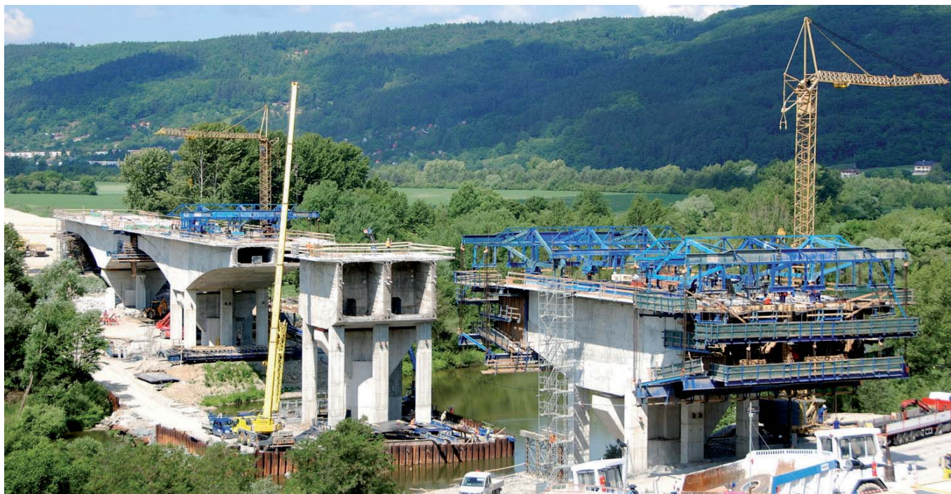
Obr. 4 Pohľad na rozostavaný most Fig. 4 A view of the bridge under construction
