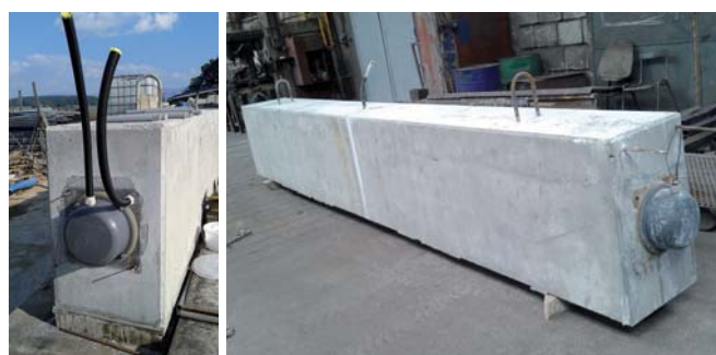
Obr. 9 Skúšobný trám so zabudovaným EI 19-lanovým káblom PROJSTAR CH Fig. 9 Testing beam with the built-in electrically isolated 19-strands tendon PROJSTAR CH
