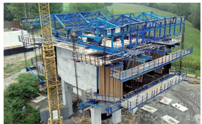
Obr. 3 Betonáž zárodku a prvých 3 m lamiel na betónovacích vozíkoch Fig. 3 The concreting of the pier segment and the first 3 segments constructed by the form travellers
