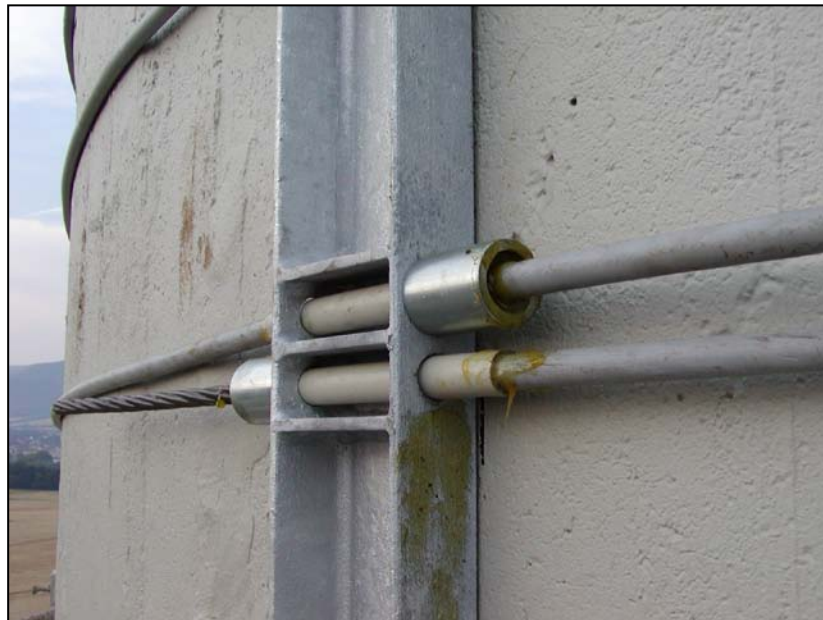
Obr. 4. Kotvenie predpínacieho lana v oceľovom rebre
