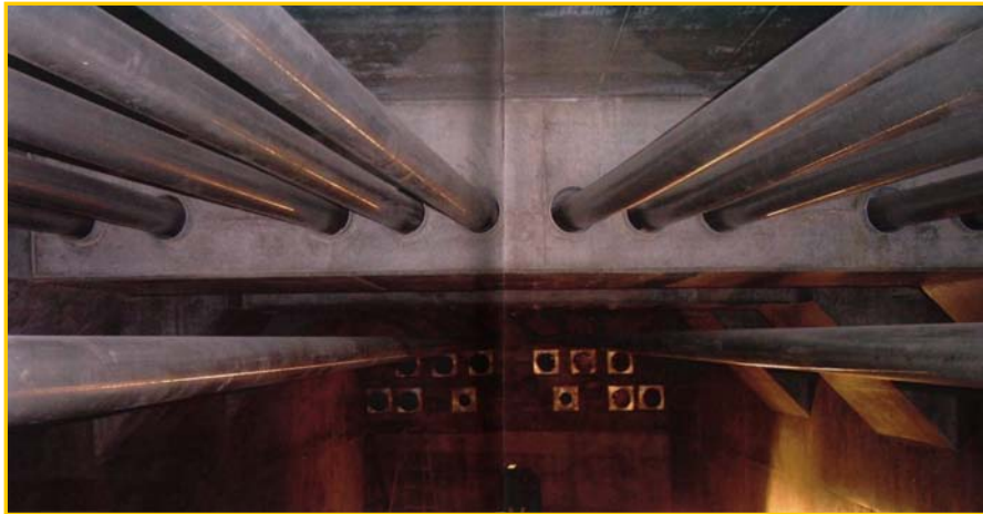
Obr.10 Vonkajšie káble s priesvitnými rúrami
