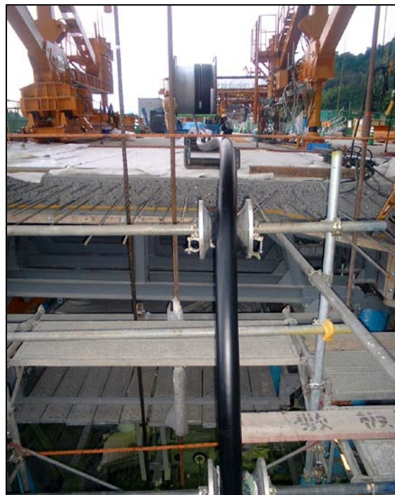
Obr.10 Vonkajšie káble s priesvitnými rúrami
