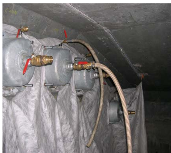
Obr.15 Technologické zariadenie na zohrievanie a injektáž maziva
