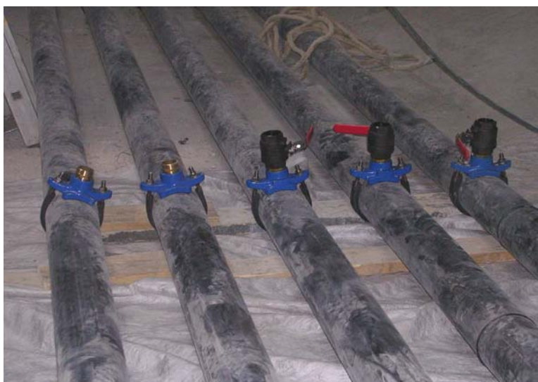
Obr.14 Vonkajšie káble mosta Sioule. Injektažne ventily na HDPE rúrach.
