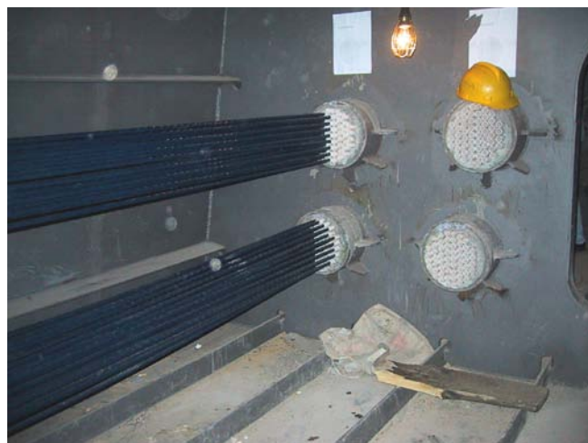
Obr.9 Separácie lán v deviátore. Individuálna montáž a napínanie lán.
