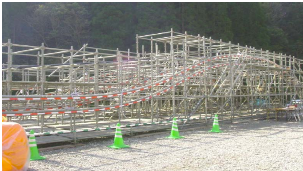
Obr.12 Skúšky HP PCG injektážnych mált na skutočnej konfigurácii káblov
