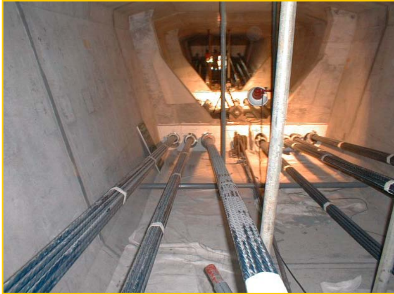
Obr.8 Príklady použitia lán chránených epoxidom
