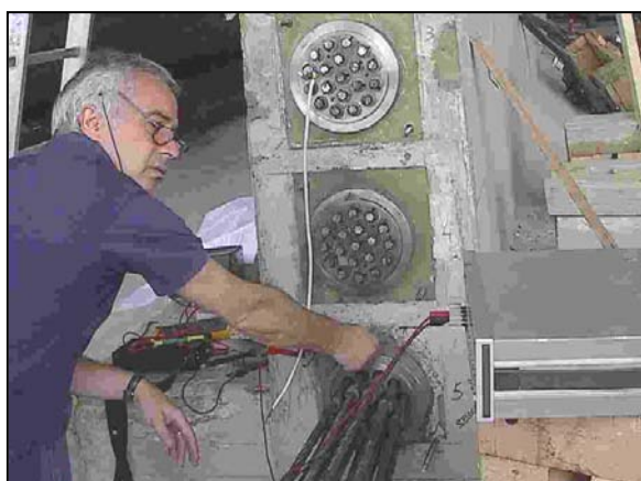
Obr.5 Meranie izolačného odporu
