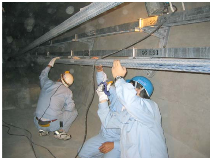
Obr.9 Separácie lán v deviátore. Individuálna montáž a napínanie lán.
