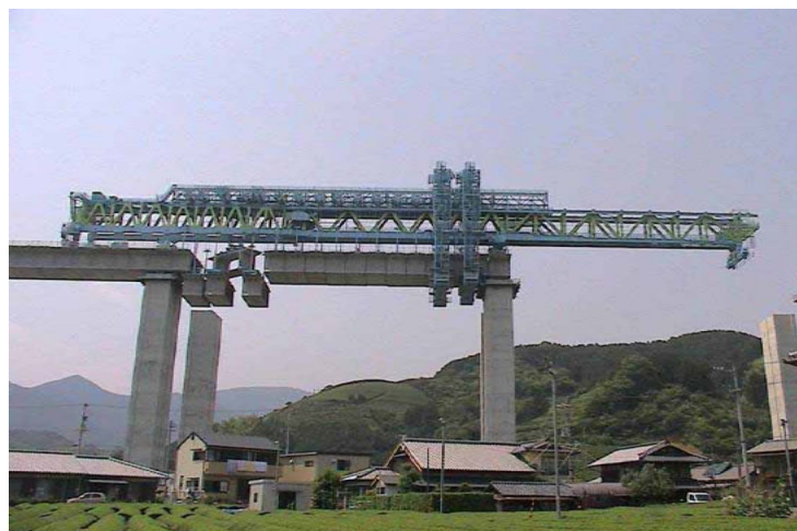
Obr.8 Priečný rez a výstavba Uchimaki viadukt–Japonsko. Celková dĺžka 1,048 km. Dĺžka polí 51 - 53 m (foto autor príspevku).
