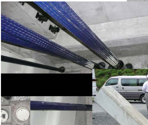
Obr.7 Vysúvaný most Katsurashima Japonsko s totálnym vonkajším predpätiím TVK (foto autor príspevku).
